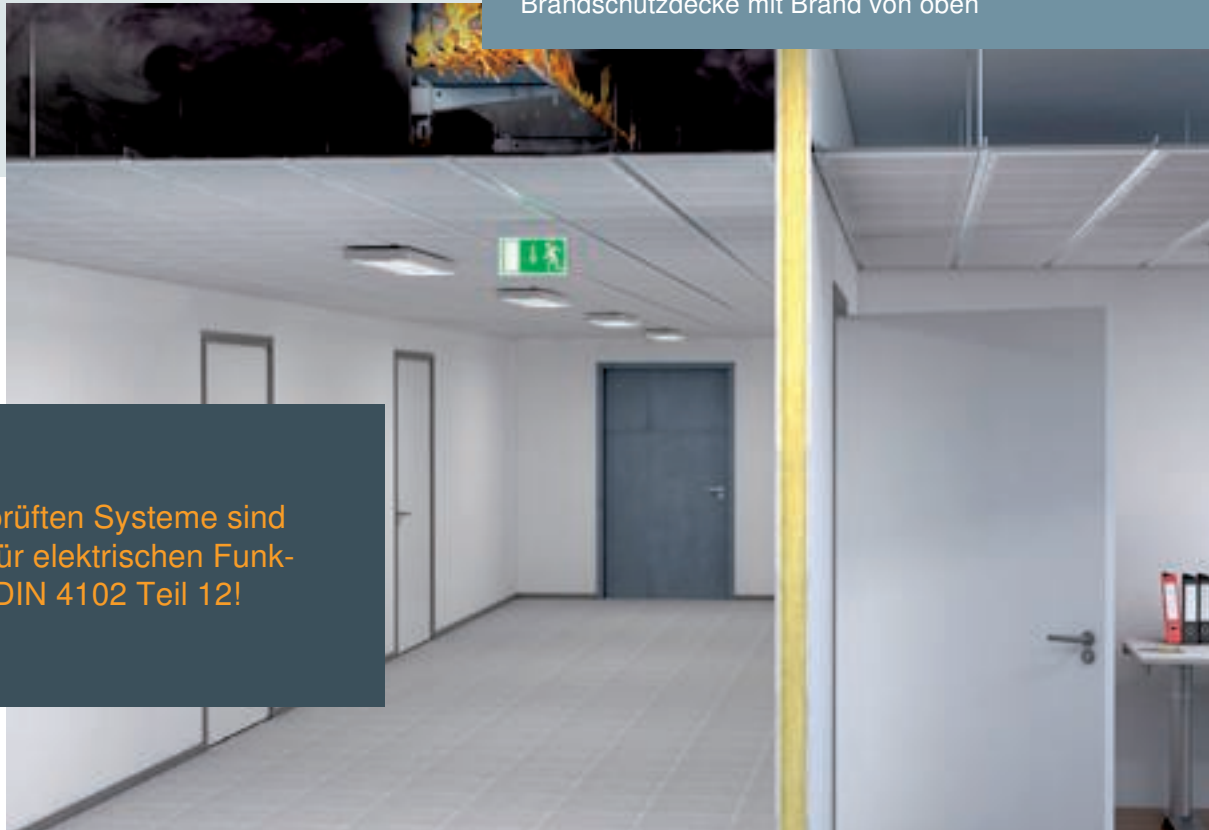
Brandschutzdecke mit Brand von oben
